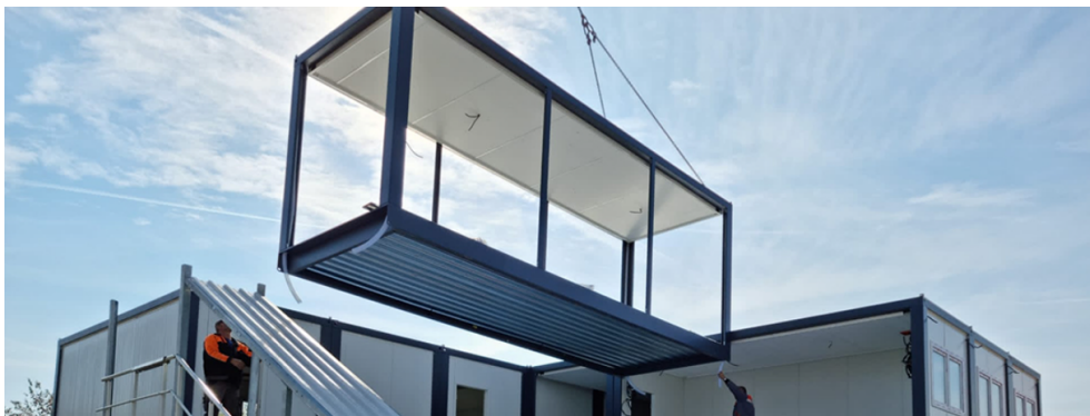
Figura 1.4 Construcción modular de Dorce (Imagen extraída de la referencia[9]).
