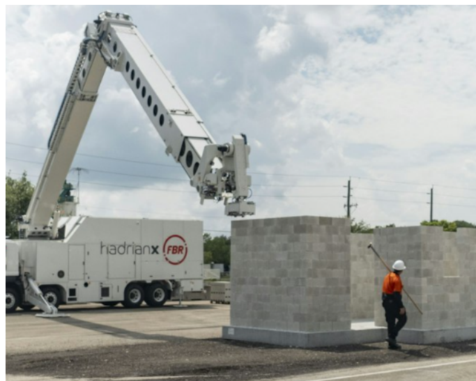
Figura 1.2 Robot albañil de FBR Limited (Imagen extraída de la referencia[7]).
