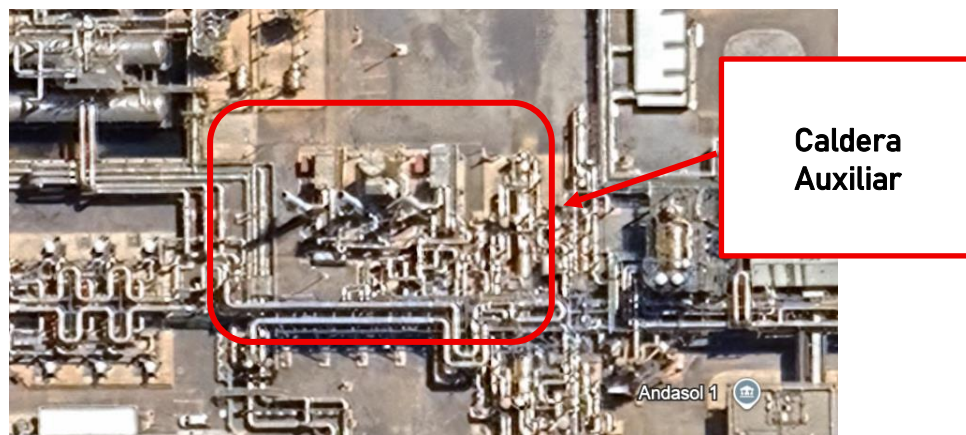
Figura 3.9. Planta termosolar Andsol 1, España. Caldera auxiliar [12].
