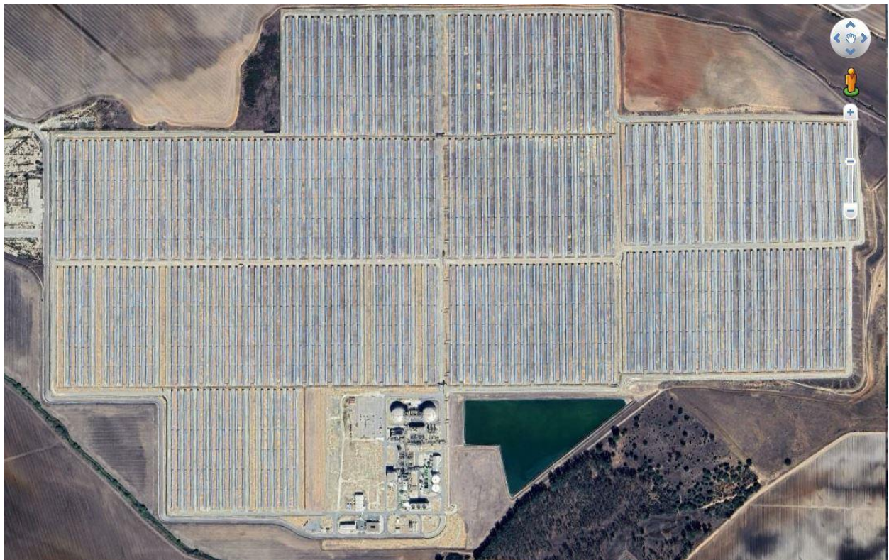
Figura 3.1. Ortofoto de la planta termosolar de Arenales [12].
