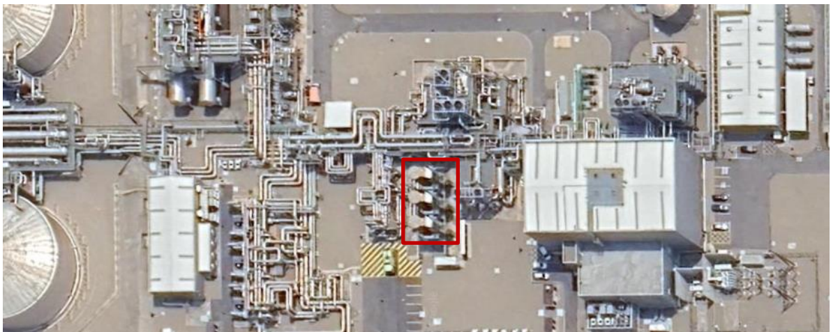
Figura 5.13. Calderas en la central termosolar “La Africana”, Córdoba [12].
