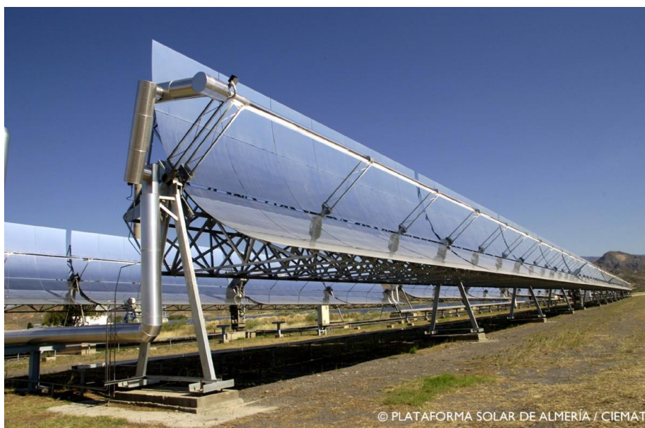
Figura 3.2. Módulo cilindro parabólico. Estructura [40].
