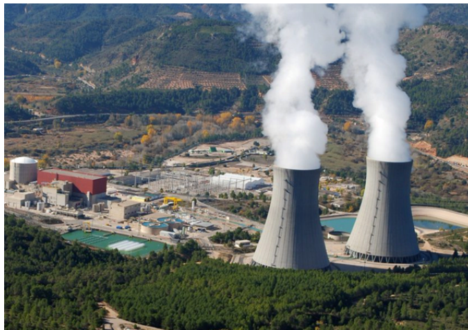
Figura 2.38 Torres de Refrigeración de tiro natural de una central térmica [35].
