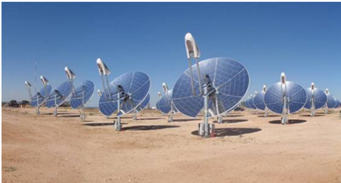
Figura 2.11 Tecnología solar de disco parabólico [22].
