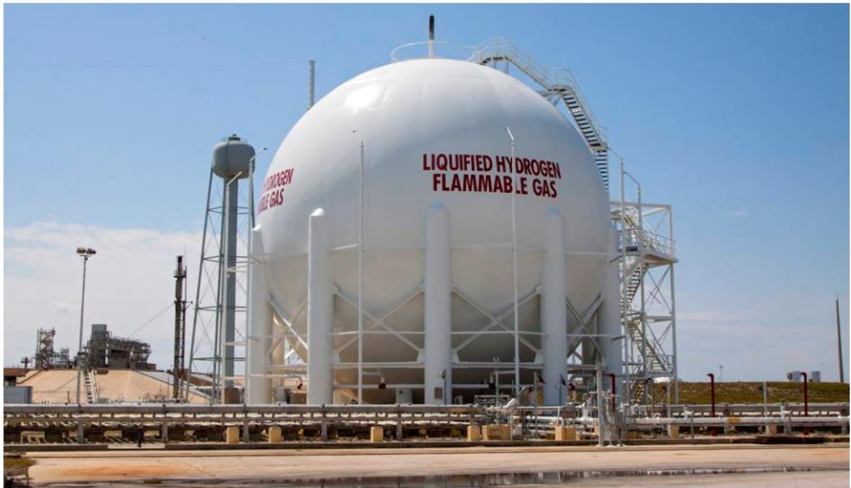
Figura 13: Tanque de almacenamiento de LH 2 de forma esférica. [21]
