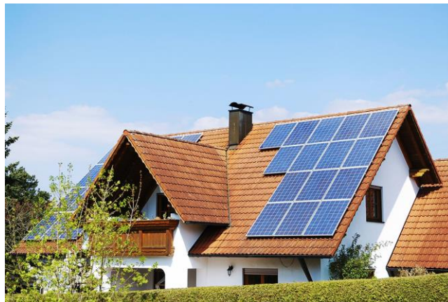
Figura 1. Vivienda unifamiliar con instalación solar fotovoltaica. [10]
