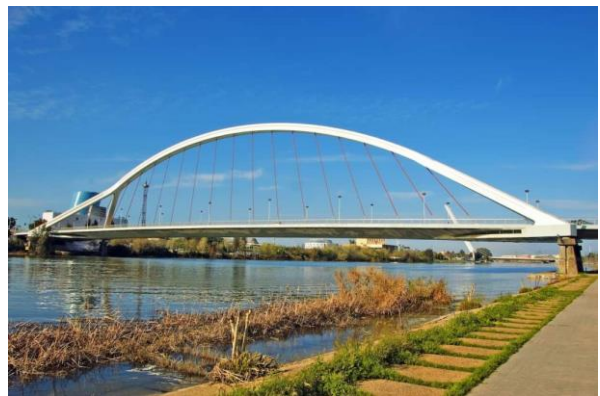
Imagen 6. Puente de la Barqueta, Sevilla [8]
