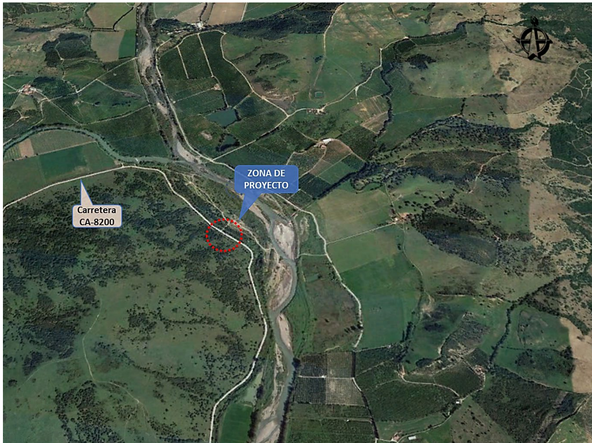
Figura 1-8. Situación del acceso objeto de trabajo. Fuente: Elaboración propia.
